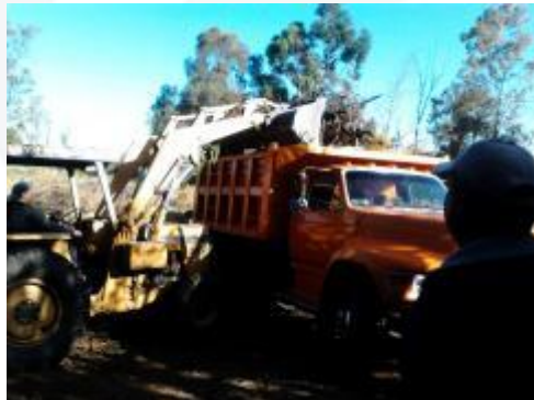
Transportación se hace en camiones cubriendo el material para no contaminar
