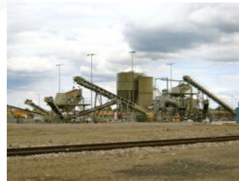
El material recuperado de la demoliciones se recicla para elaborar concretos hidráulicos
