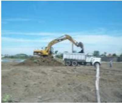
Retiro de la capa superficial del terreno natural
